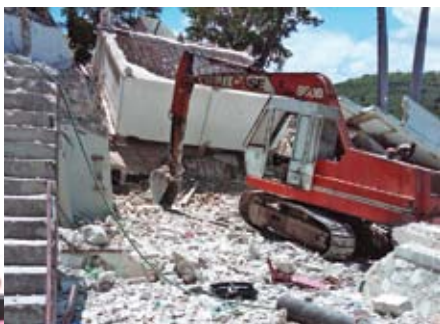
Nos nouvelles installations émergent des décombres.
