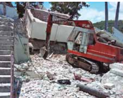
Nos nouvelles installations émergent des décombres.
